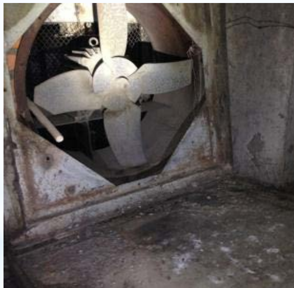
Неисправность системы дымоудаления
